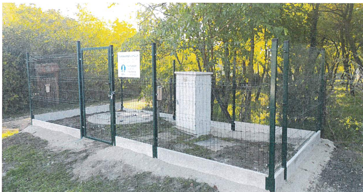
A felújított kerítés a Rákóczi u.-i átemelőnél
